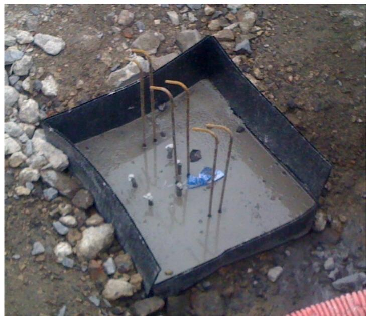
**Définition :** Le coffrage perdu en métal existe sous forme ronde ou rectangulaire. Son utilisation principale est la réalisation de réservations dans le but d'un ancrage (barre d'ancrage, encuvement de poteaux ou poutres). Les boîtes rectangulaires peuvent aussi servir de coffrages perdus en tête de pieux par exemple.
