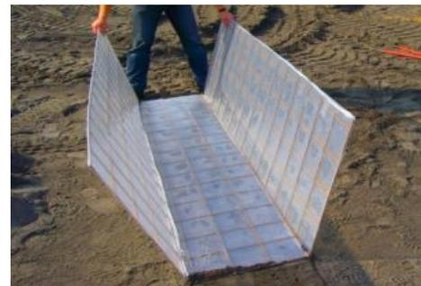
Il se révèle particulièrement avantageux puisqu'avec la mise en place des entretoises nécessaires et préfabriquées, on peut en même temps procéder à la mise en place de l'armature du béton. Ceci est rendu possible par le système de fixations mobiles qui permet de varier, selon les besoins, l'ouverture des éléments en U.
