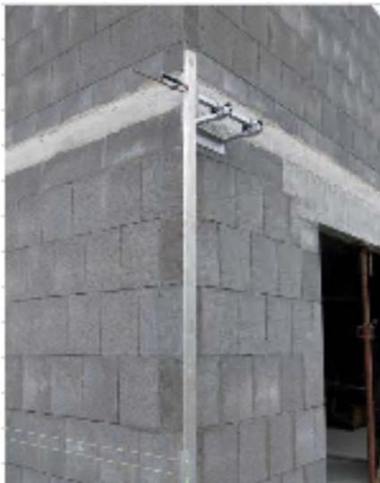
**B** à l'aide d'un sert joint, appliquer une règles d'aplomb le long des consoles porte guide situées en haut et bas de chaque extrémités
