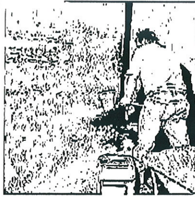
Application par projection de la première passe adjuvantée avec le LIQUIDE IDROSILEX
