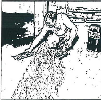
Application de la barbotine adjuvantée avec le LIQUIDE IDROSILEX
