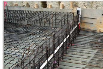
STREMAFLEX® (Arrêt de bétonnage + étanchéité)
