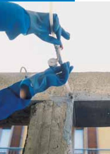
Poutres renforcées avec des plaques métalliques
