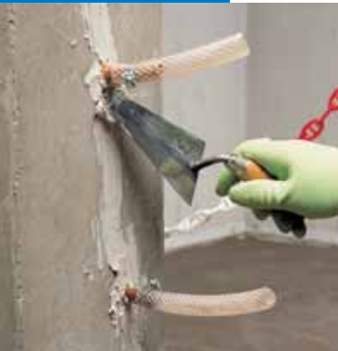
Fixation de tubes d'injection
