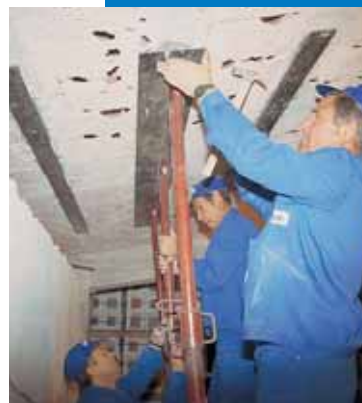
Renforcement de structures par plaquage métallique
