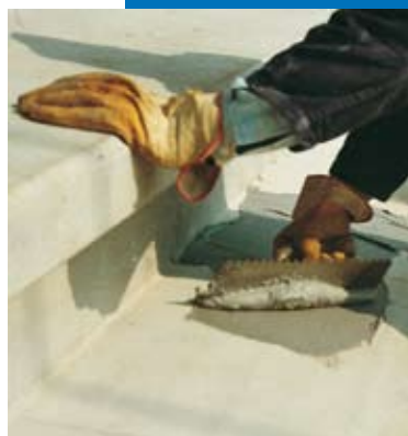
Application d'Adesilex PG1 pour collage de gradins préfabriqués
