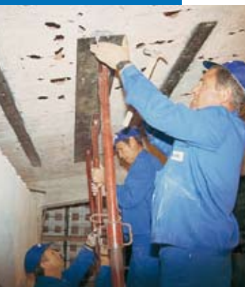
Renforcement de structures par plaquage métallique
