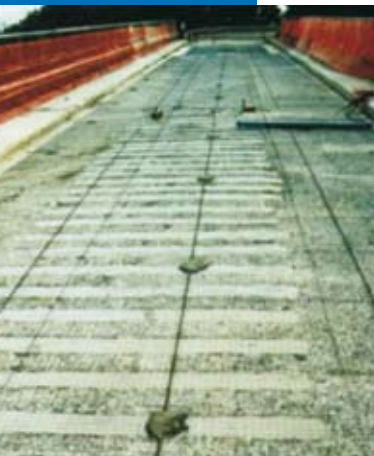
Reconstitution de la surface béton avec Mapegrout BM.
