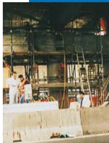
Vue du pont durant les opérations de renforcement
