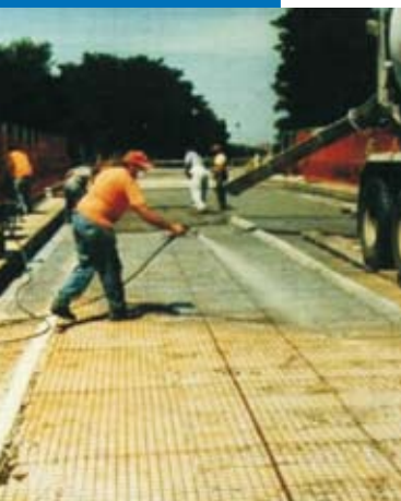
Application du primaire Epoxy
