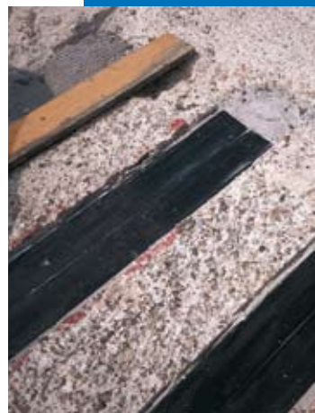
Plats Carboplate engravés dans le béton
