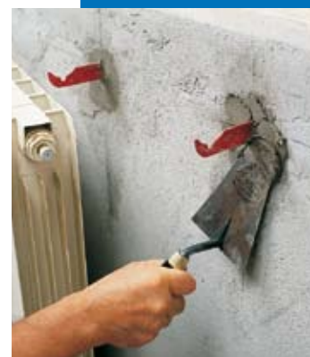
Fixation de supports pour radiateur avec Lampecem
