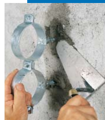
Fixation de colliers pour canalisation avec Lampecem
