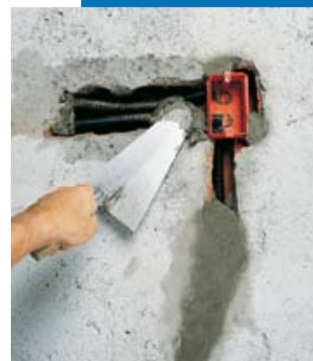
Fixation de boîtes et de fourreaux électriques avec Lampecem
