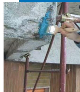
Application au pinceau de Mapefer 1K sur des armatures de balcon en béton armé
