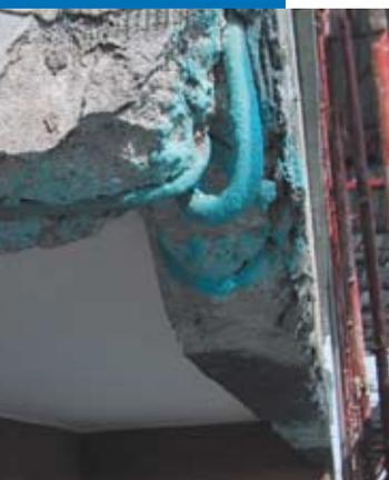
Armatures d'une allège de balcon traitées avec Mapefer 1K
