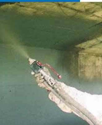
Application par projectin de Mapelastic sur un viaduc.
