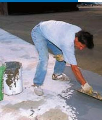
Imperméabilisation d'une piscine avec Mapelastic
