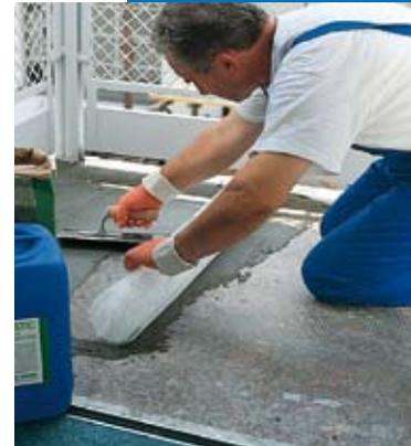
**Imperméabilisation d'un balcon avec Mapelastic et application d'un treillis en fibre de verre**
