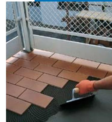
**Pose de carrelage avec Granirapid sur un balcon imperméabilisé à l'aide de Mapelastic**
