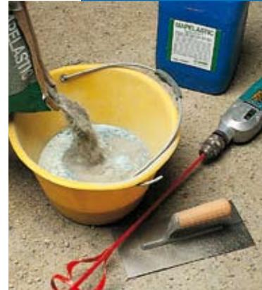
**Gâchage de Mapelastic avec malaxeur mécanique**
