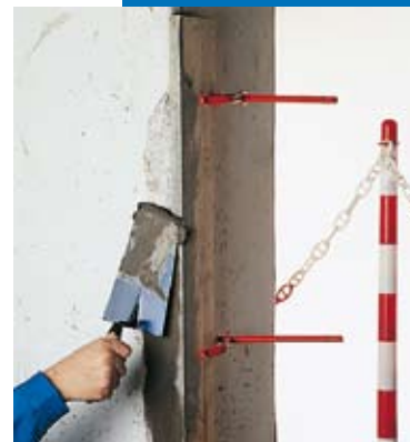
Réparation d'une arête
