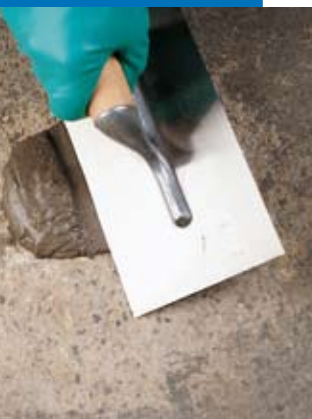
Rebouchage sur un sol en béton
