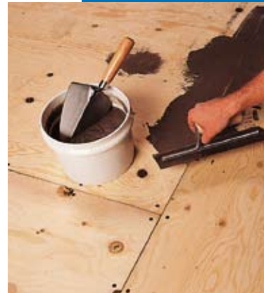
Application sur plancher bois de Nivorapid + Latex Plus
