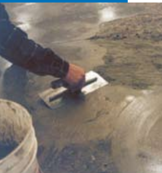
Réparation d'un sol industriel
