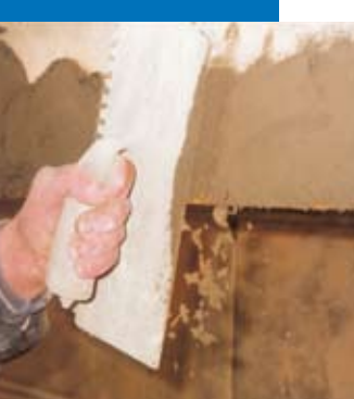
Réparation d'une allège de balcon : finition du mortier
