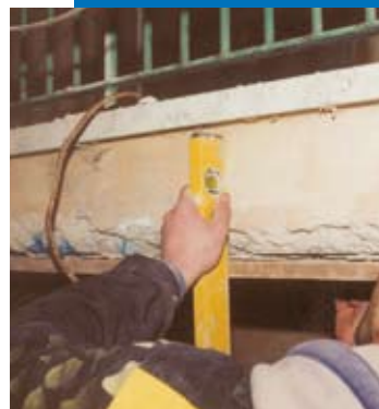
Réparation d'une allège de balcon: positionnement du coffrage
