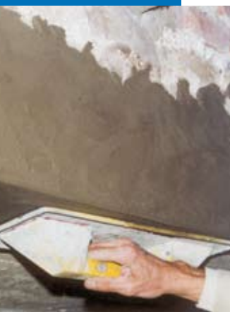
Réparation d'une poutre en béton
