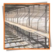
Le STREMAFORM® est le produit idéal pour vos arrêt de bétonnage lors de la réalisation de dalles ou de voiles radier.
