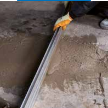
Réglage de Mapegrout SV Fiber
