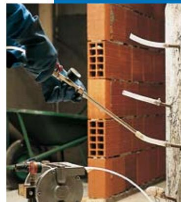
Injection d'Epojet dans un pilier fissuré
