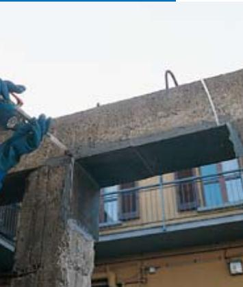
Injection d'Epojet dans des poutres renforcées avec des plaques métalliques
