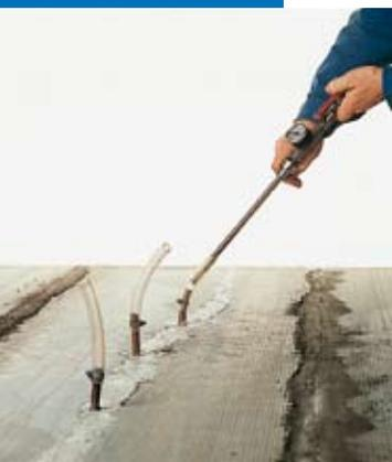
Rénovation par injection des structures horizontales
