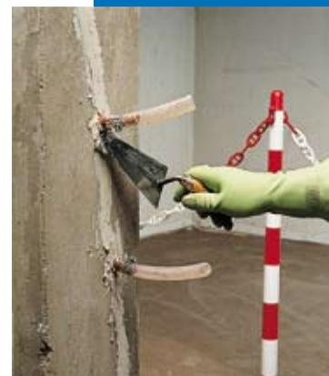
Fixation des injections avec Adesilex PG1
