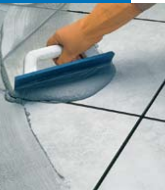
Jointoiment de carrelage en sol à l'aide d'une spatule caoutchouc
