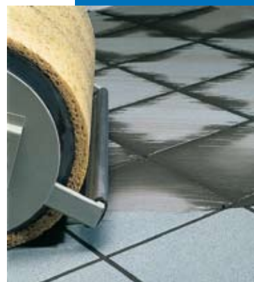
Finition des joints en sol à la machine
