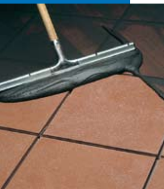
Jointoiment de terre cuite en sol à l'aide d'une raclette
