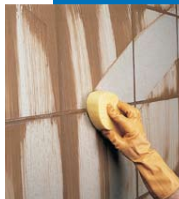
Finition des joints en mur à l'éponge
