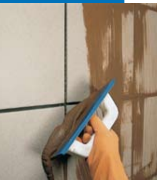
Jointoiment en façade à l'aide d'une spatule
