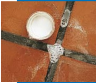
Elimination des efflorescences
