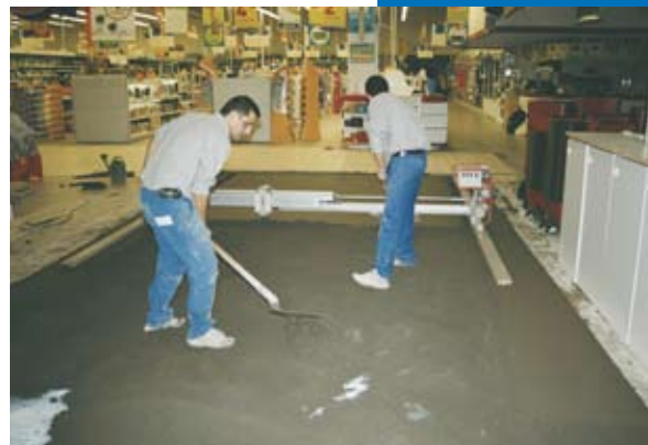
Mise en place et lissage de la chape à la machine
