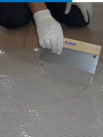
Application de la 1 ère passe de Mapelastic Smart
