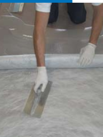
Mise en place de l'armature Mapetex SEL dans la 1 ère passe de Mapelastic Smart
