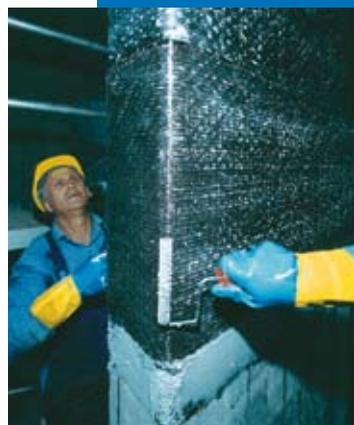
*Marouflage des tissus Mapewrap dans Mapewrap 31 frais en utilisant un rouleau en caoutchouc rigide pour permettre la bonne pénétration de la résine dans les fibres du tissu*
