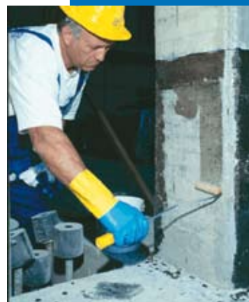
Application de Mapewrap Primer 1
