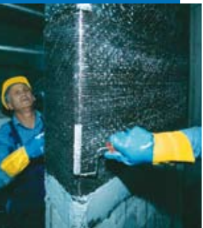
Marouflage de Mapewrap C Uni-Ax dans Mapewrap 31
