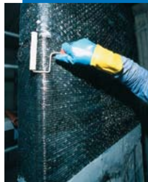
Application de la seconde passe de MapeWrap 31
