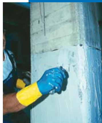
Ratissage éventuel avec Mapewrap 11 ou Mapewrap 12
