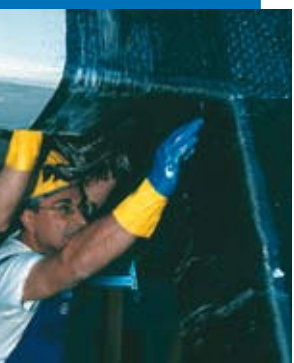
Renforcement d'un nœud poteau/poutre
