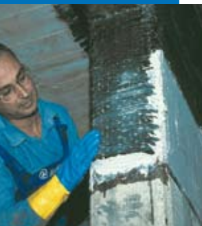
Renforcement d'un poteau et d'une poutre
