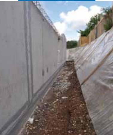
Étanchéité de joint dans un mur enterré
