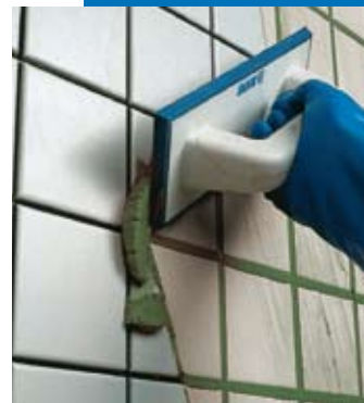
Jointoiment en mur avec la spatule caoutchouc
