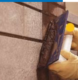
Autre exemple d'application d'Ultracolor Plus à la spatule en caoutchouc en mur
