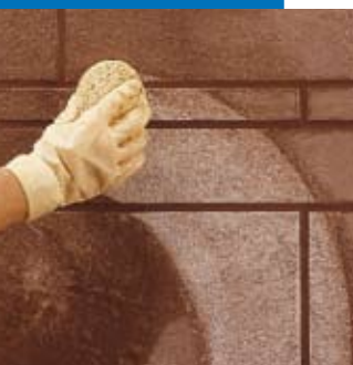
Nettoyage et finition des joints à l'éponge
