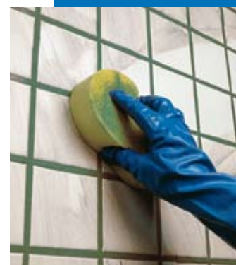
Nettoyage et finition des joints à l'éponge, en mur
