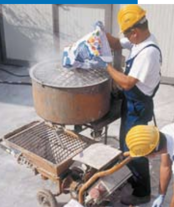
Préparation mécanique du produit avant pompage
