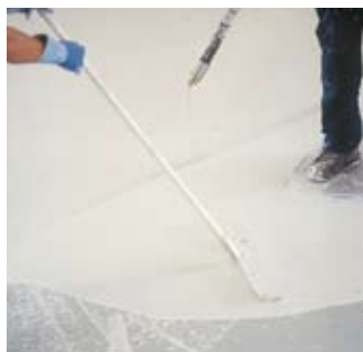
Application mécanique d'Ultratop
