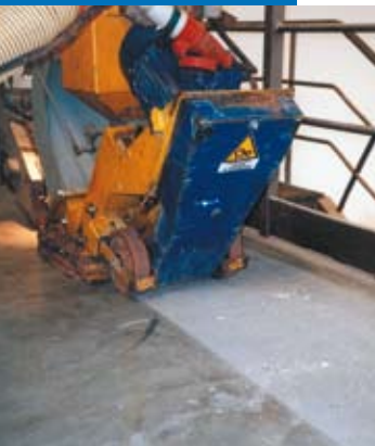
Préparation du support par grenailage
