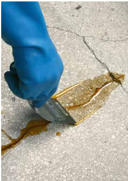
Comblement de la fissure
