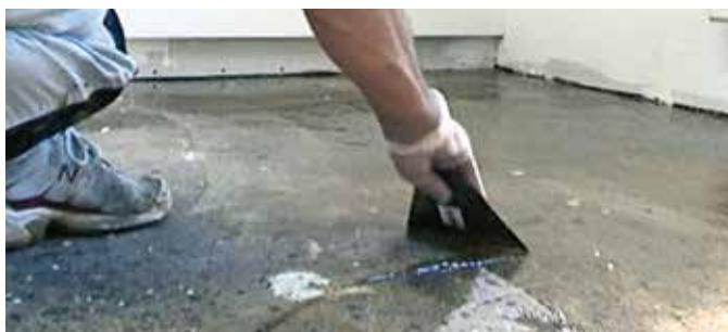
Comblement de la fissure
