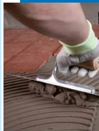
Mise en œuvre de Granirapid sur Mapelastic
