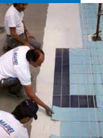
Pose d'un revêtement céramique sur Mapelastic
