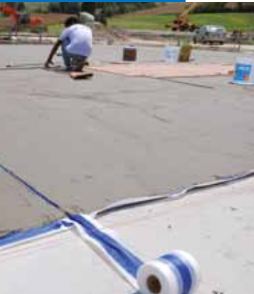
Imperméabilisation des supports avec Mapelastic et Mapeband
