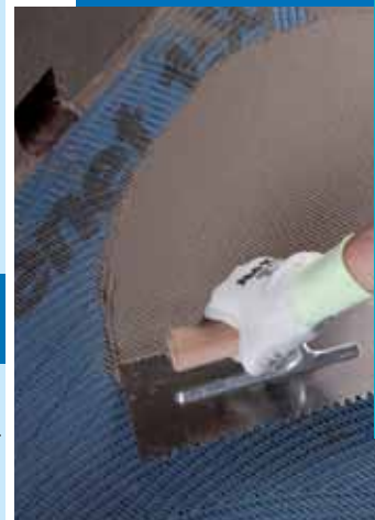
Application d'une couche de Mapelastic sur Mapenet 150
