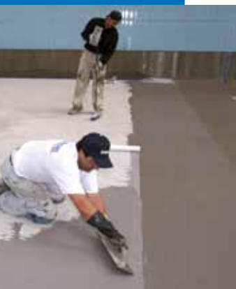
Imperméabilisation d'une piscine avec Mapelastic
