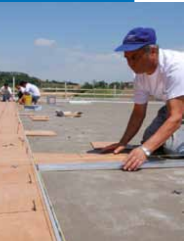
Pose de carrelage avec Kerabond T + Isolastic
