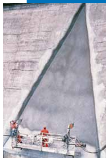
Exemple d'application à la pompe à mortier de Mapelastic sur un barrage
