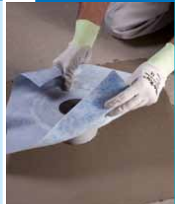
Pose d'un siphon de sol sur Mapelastic
