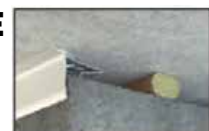
Bourrelet coupe feu avec couvre joint.
