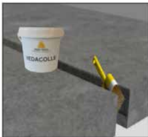
Encoller les deux côtés du joint avec la colle silicate
