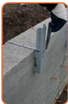
4. Pose de la clavette de blocage
