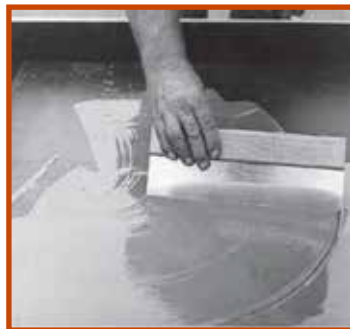
Mise en oeuvre
