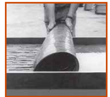
Mise en place de la matrice
