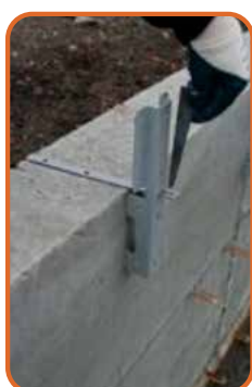
4. Pose de la clavette de blocage
