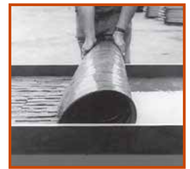
Mise en place de la matrice
