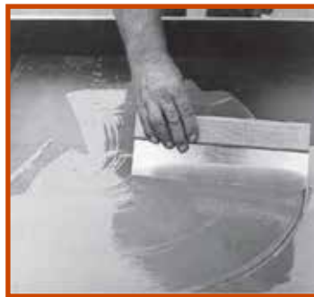
Mise en oeuvre
