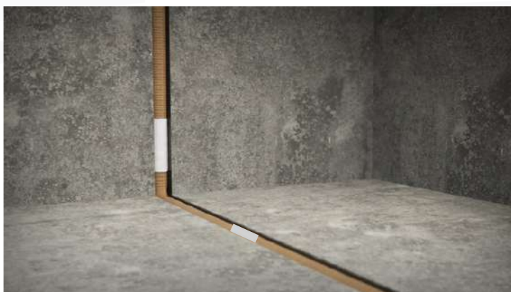
Traitement de joints de sols et de murs avec raccords.
