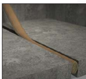
Avant que la colle ne sèche, introduire le cordon VEDAFEU C ® .
