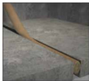
Avant que la colle ne sèche, introduire le bourrelet
