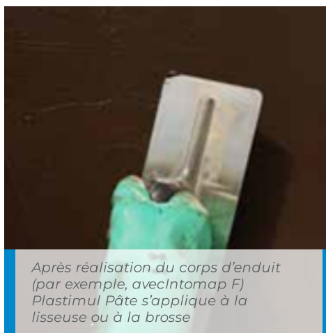
Si nécessaire, appliquer une 2ème couche après séchage complet de la 1ère
