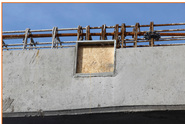
Raidisseur en OSB résistant à la pression du béton.
