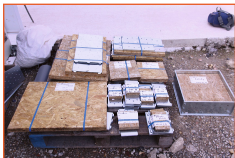
Boîte bi-matière livrée en kit pour optimiser le stockage sur chantier.
