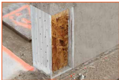
Raidisseur en OSB résistant à la pression du béton.
