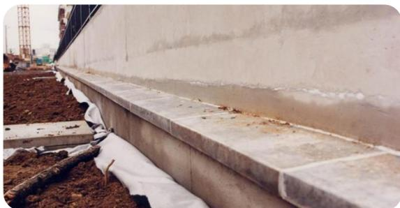
Système de protection des relevés d'étanchéité correspondant au D.T.U. 20.12 - NF P10-203-1/A2.
