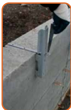
4. Pose de la clavette de blocage
