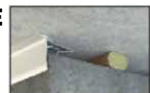
Bourrelet coupe feu avec couvrir joint.
